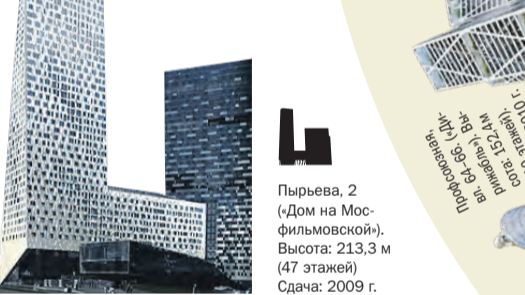
Пырьева, 2 («Дом на Мосфильмовской»). Высота: 213,3 м (47 этажей). Сдача: 2009 г.
